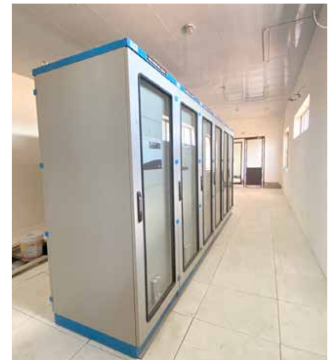
Khu trạm biến áp của dự án đang dần định hình hoàn thiện.
